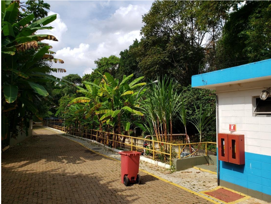
Foto 3 – EFRF da SABESP instalada no Ibirapuera. Fonte: PMSP.
